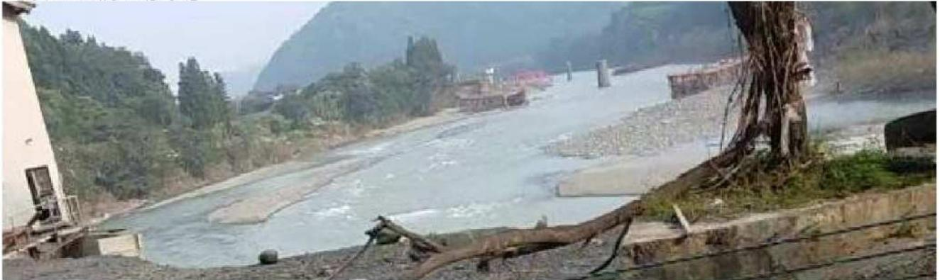
明治時代にドイツ人が設計し敷設された肥薩線も、ありとあらゆる所で、線路が寸断され渡の橋脚も倒壊しています。立ち止まって写真に収めるのもはばかれ、トラックで走りながら取った動画のショットです。
